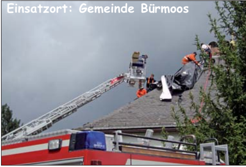
Abdecken der zerstörten Dächer
